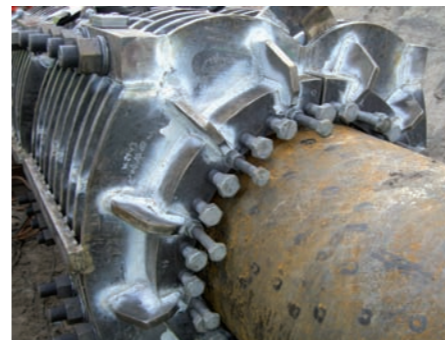
Die fertig montierten Klammern (Quelle: IBW)
