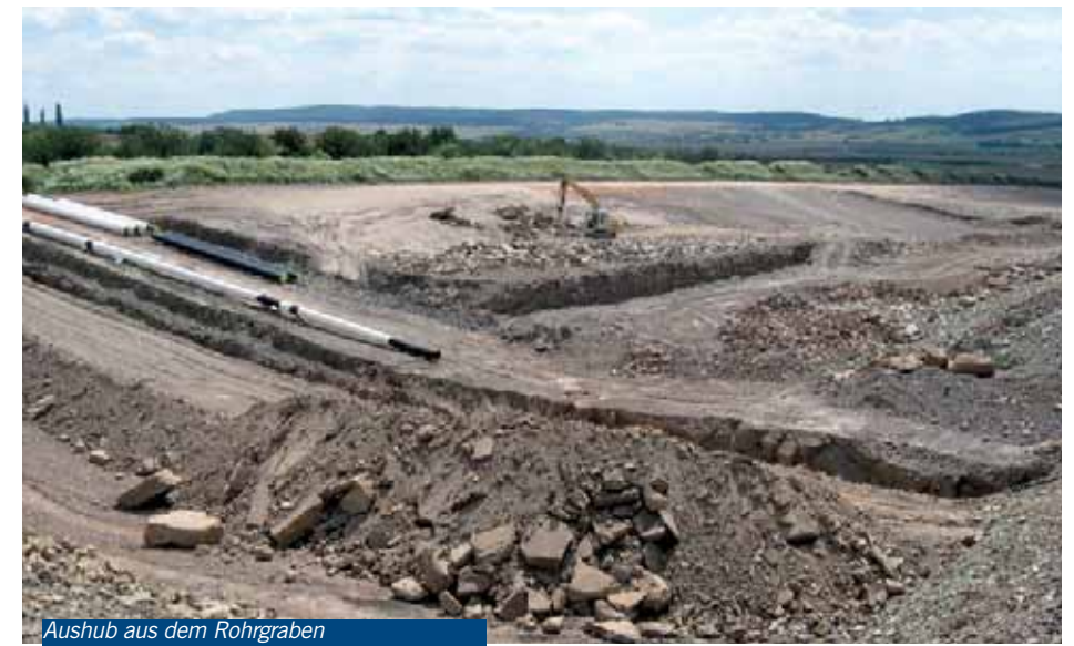
Aushub aus dem Rohrgraben
