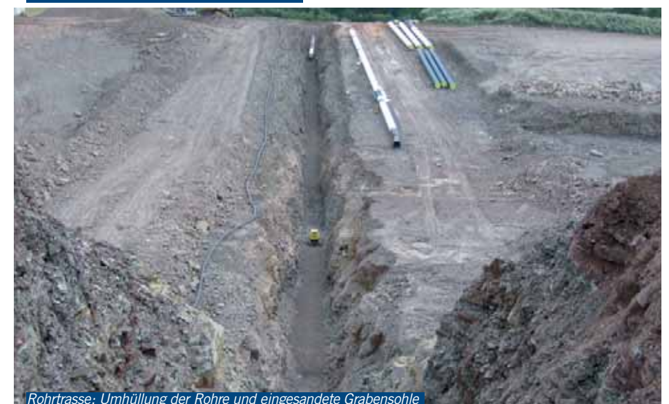
Rohrtrasse: Umhüllung der Rohre und eingesandete Grabensohle
