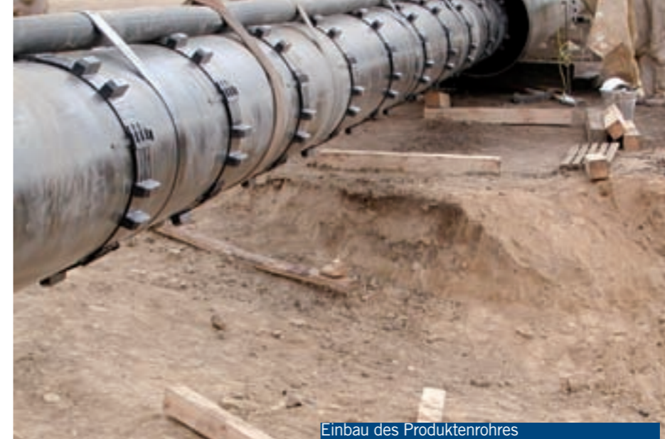
Einbau des Produktrohres
