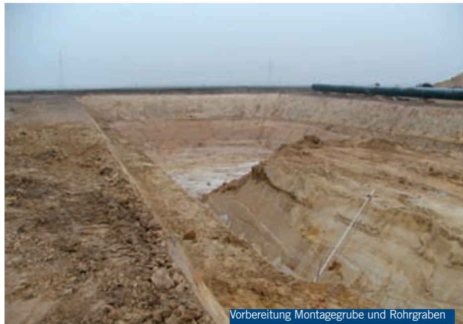
Vorbereitung Rohrgraben und Wasserhaltung
