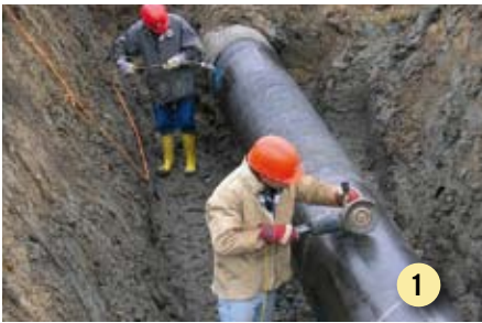
Bild 1: Vorbereitung der Rohroberfläche für das Black-Diamond-Verfahren durch Bürsten und Trocknen.
