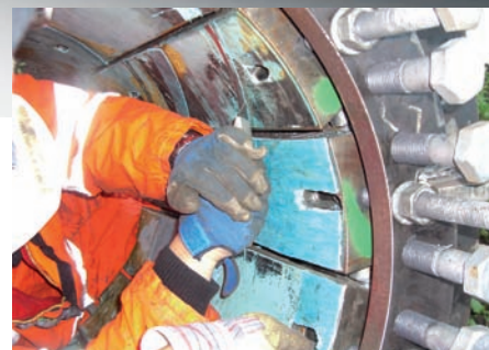
Aussparen der Spiralnaht in der Auflagefläche der Klammer aussparen (Quelle: IBW)
