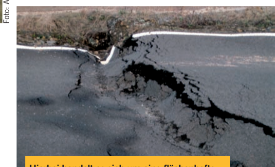
Hierbei handelt es sich um eine flächenhafte Absenkung im Kippengebiet eines Tagebaus.
