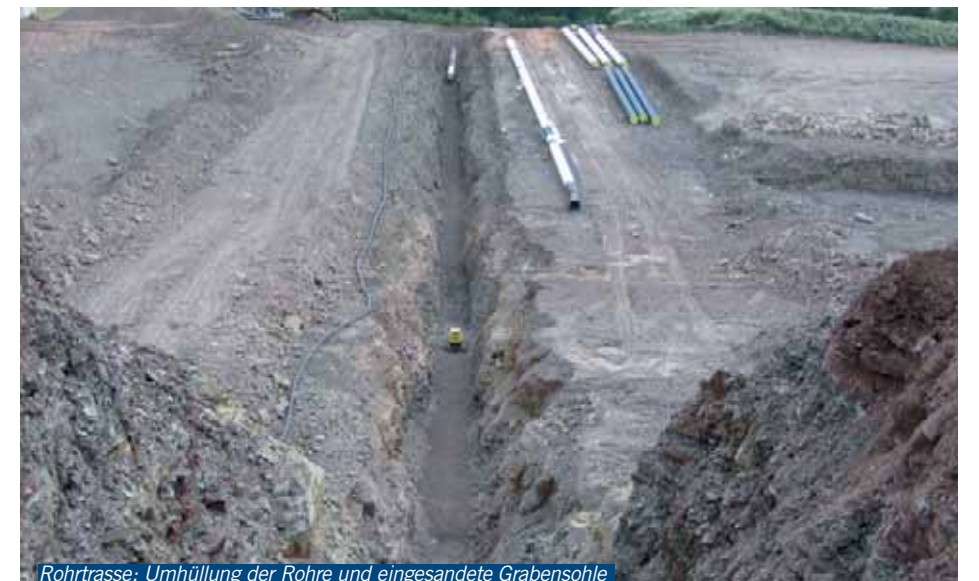
Rohrtrasse: Umhüllung der Rohre und eingesandete Grabensohle
