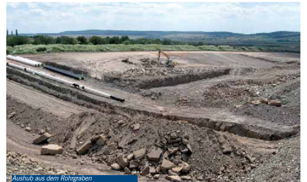
Aushub aus dem Rohrgraben
