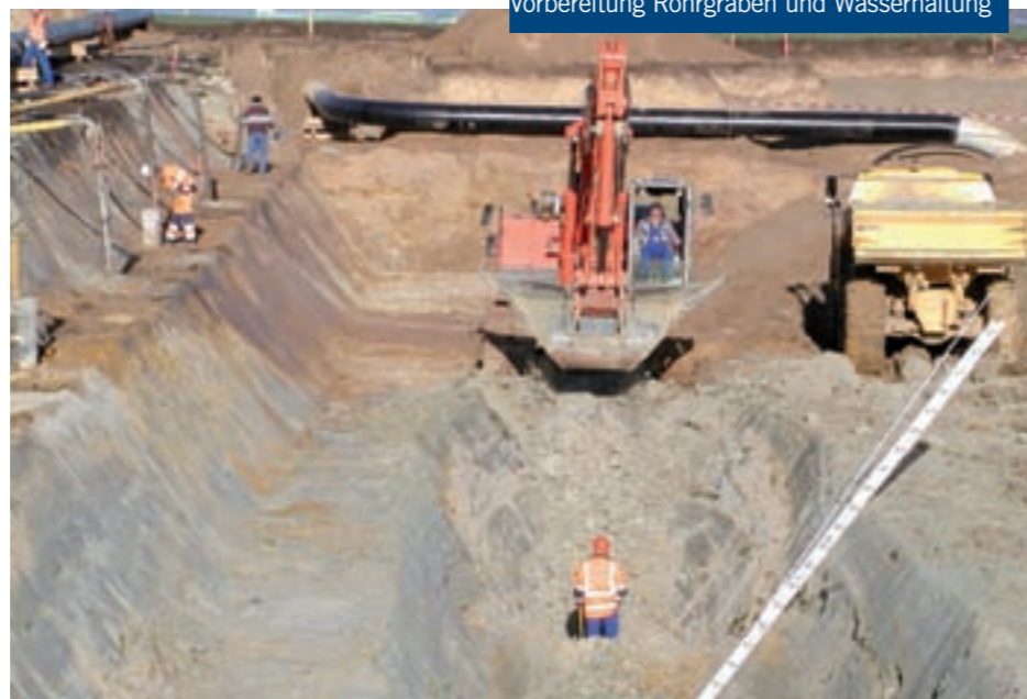
Vorbereitung Rohrgraben und Wasserhaltung
