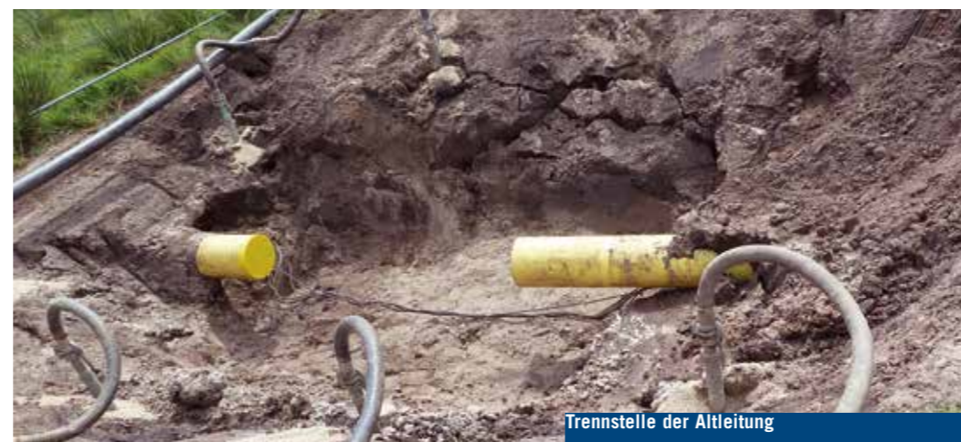
Altleitungsstrang und betonummantelte neue Leitung nebeneinander
